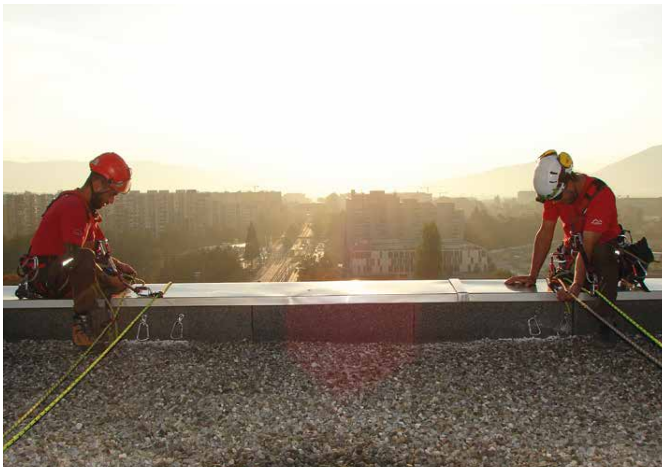
Rigging the descent for access to work on the installation of a neon sign. Preparación del descenso para la instalación de un cartel de neón. Genève, Switzerland (courtesy of Corde-Access SA).
