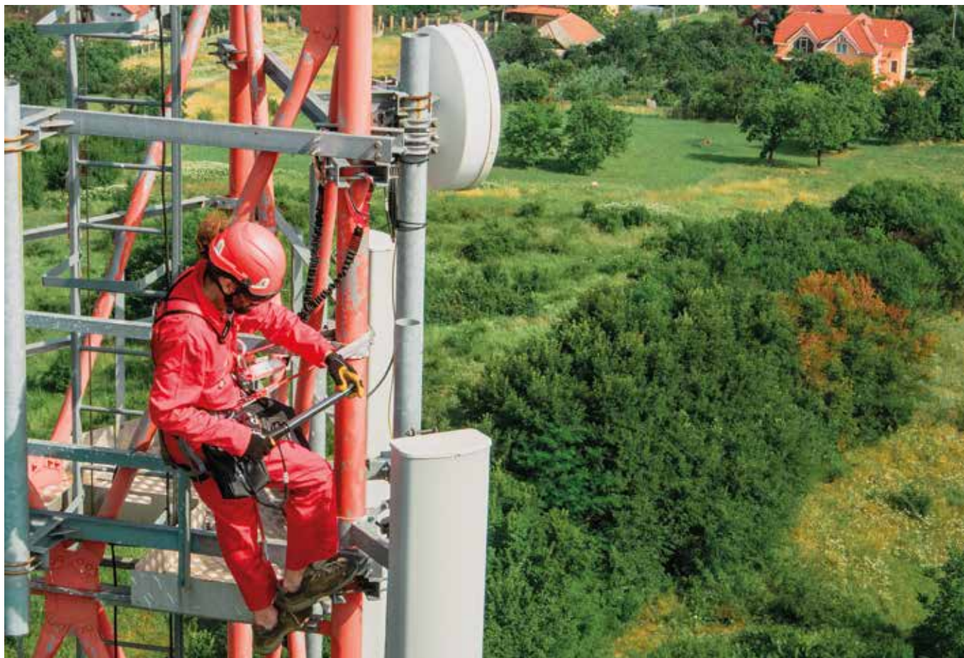
Installation of antennas on a telecommunication tower. Instalación de antenas encima de una torre de telecomunicaciones. Oradea, Romania (courtesy of Camp Technical Solutions, ph. Amazing Visuals Studio).
