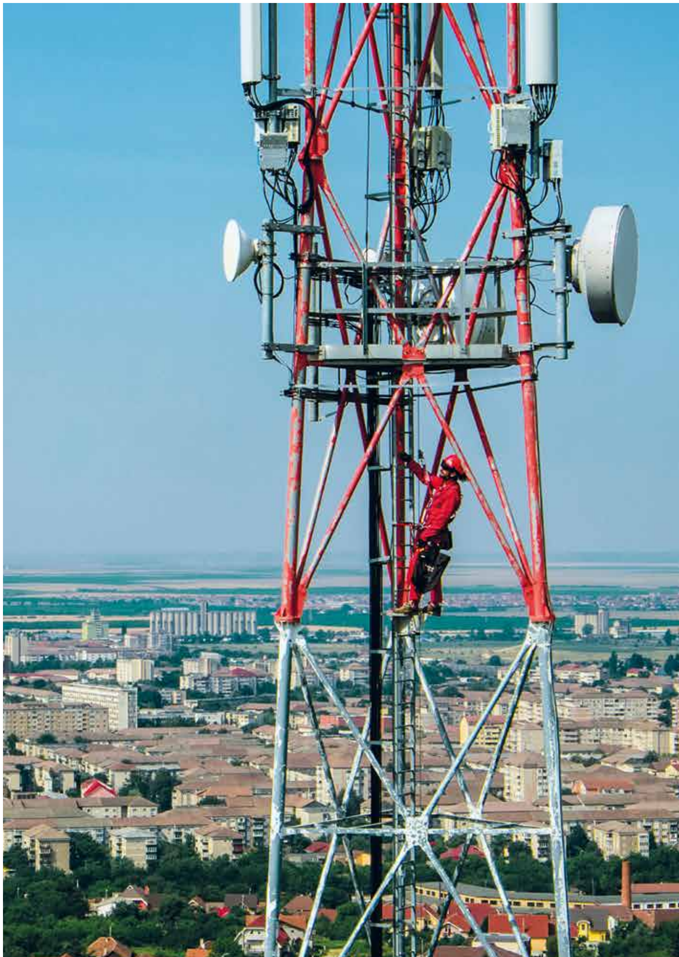
Installation of antennas on a telecommunication tower. Instalación de antenas encima de una torre de telecomunicación. Oradea, Romania (courtesy of Camp Technical Solutions, ph. Amazing Visuals Studio).
