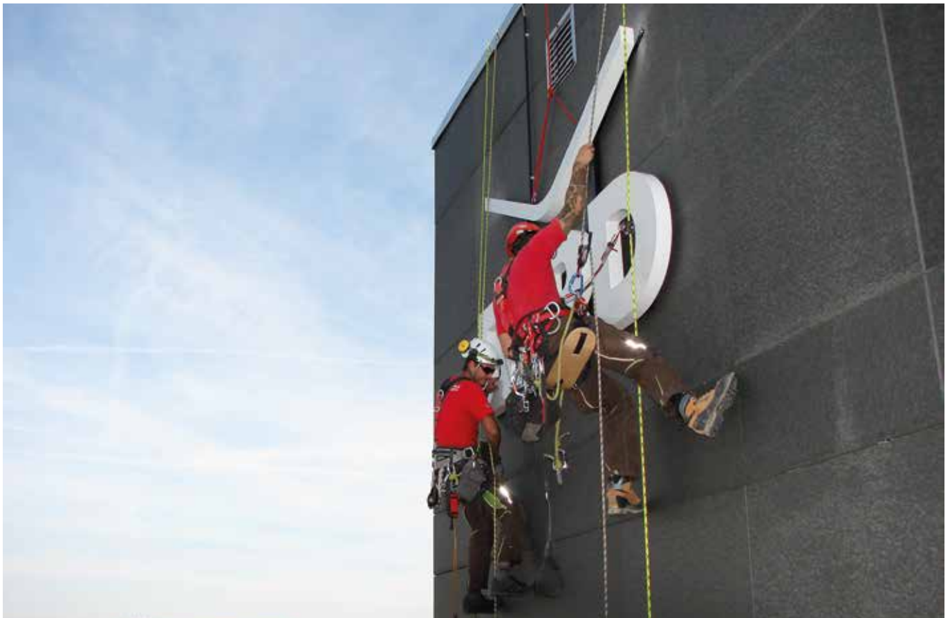
Installation of a neon sign. Instalación de un cartel de neón. Genève, Switzerland (courtesy of Corde-Access SA).
