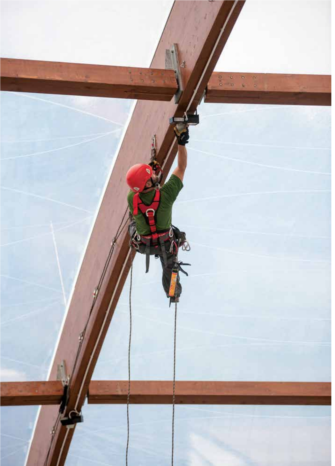
Technical access to electrical work inside the cupola of the Aquapark Nymphaea. Trabajos eléctricos en el interior de la cúpula del Aquapark Nymphaea. Oradea, Romania (courtesy of Camp Technical Solutions, ph. Riky Felderer).
