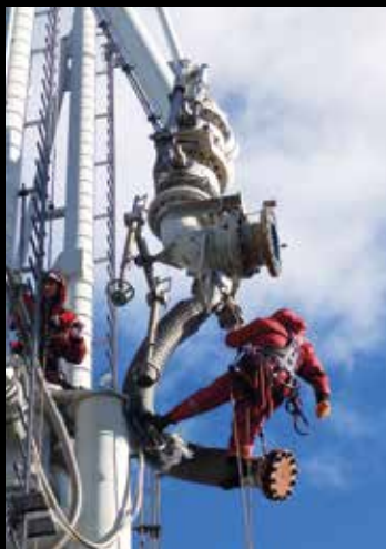
Maintenance on naval refueling standpipes. Operaciones de mantenimiento de tubos de repostaje portuarios. Harbor of Sillamäe, Estonia (courtesy of Extreme Works OÜ, ph. Artem Krasnenko).
